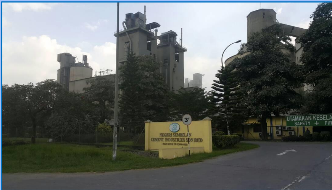
CIMA Bahau Cement Plant, Negeri Sembilan
